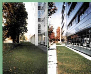
Accès pompiers : l'engazonnement permet de réduire la température extérieure à proximité immédiate du bâtiment. La dalle gazon allie esthétique et solidité.
